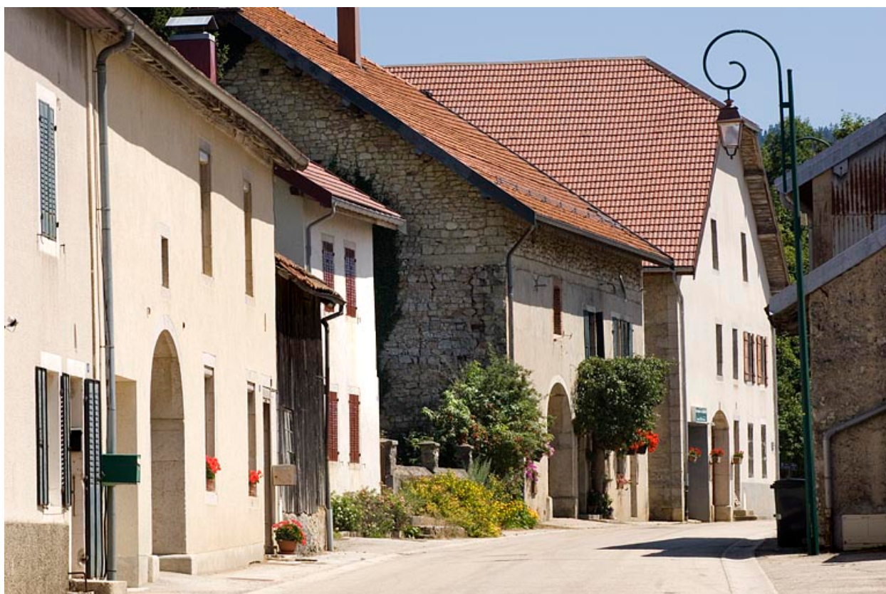
Fermes situées rue du Faubourg.
