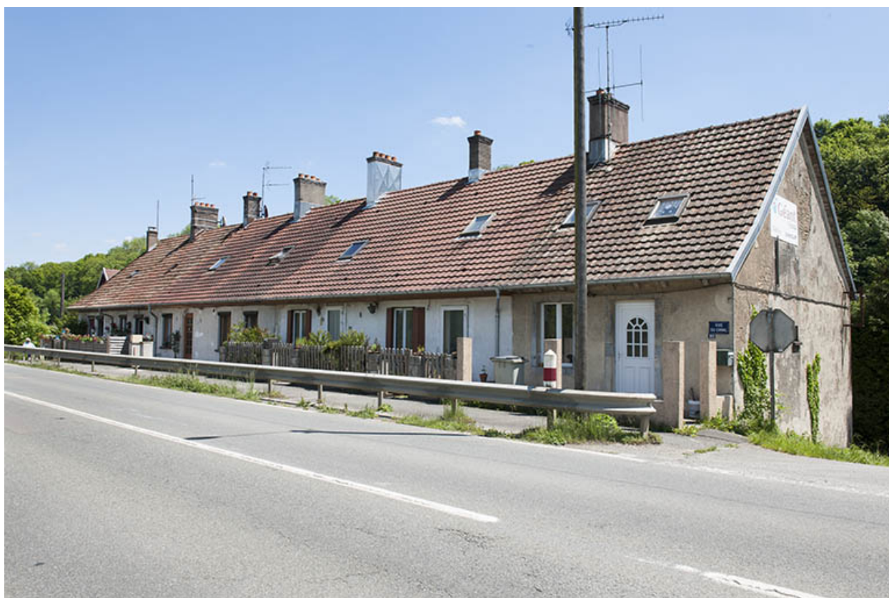
Habitation de type caserne (commune de Colombier-Fontaine).
