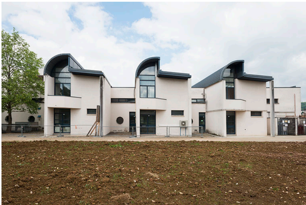
Façades postérieures sud-est des ateliers.
