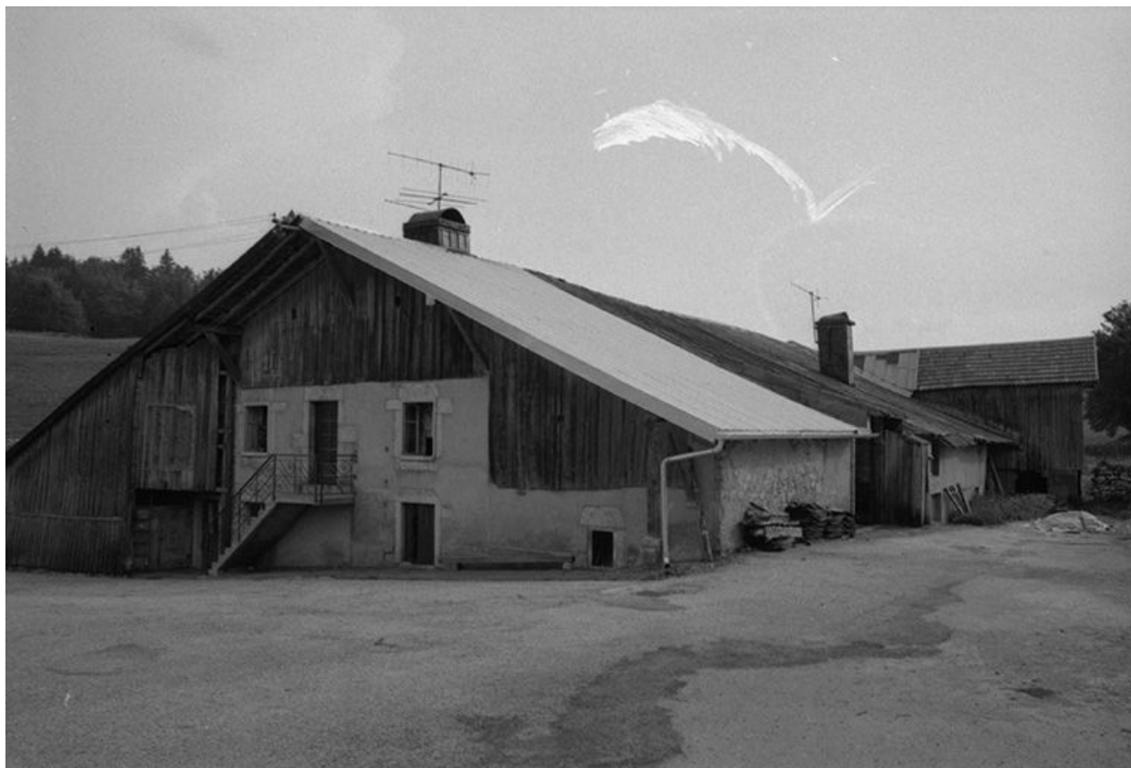
Façades antérieure et latérale droite.
