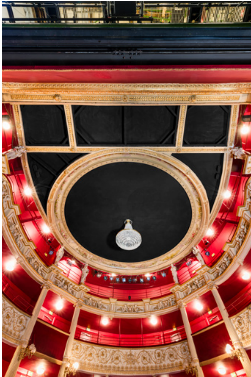
Vue d'ensemble du plafond.
