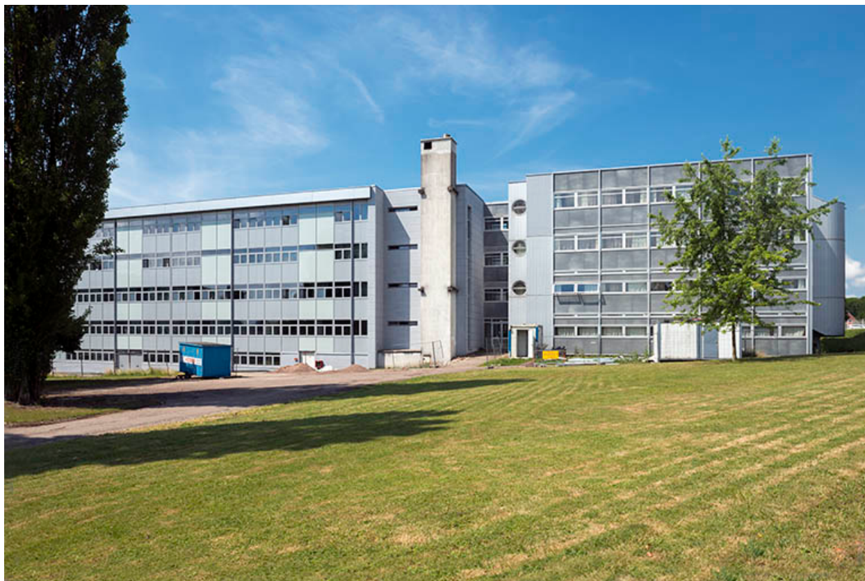
Façades orientales des externats.
