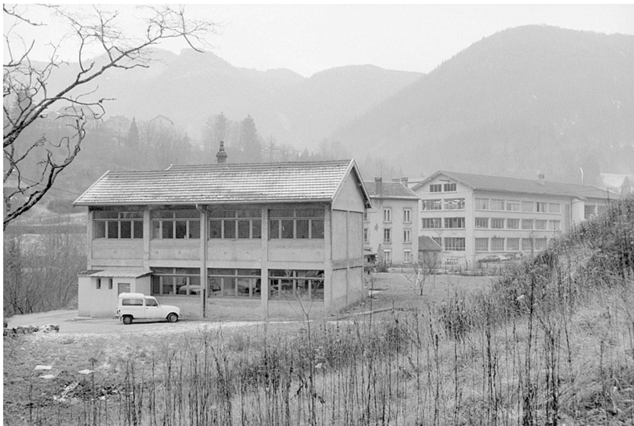
Façade latérale de l'atelier de fabrication.
