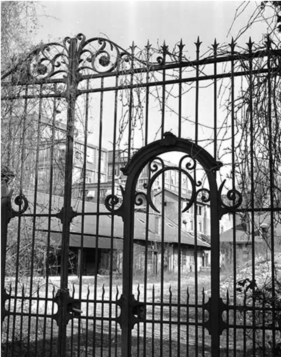
Détail de la grille d'entrée.
