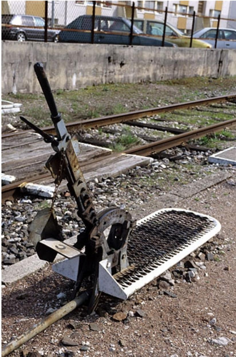
Levier de manoeuvre enclenché de l'appareil de voie C, à la jonction des voies 1 (A) et 11.
