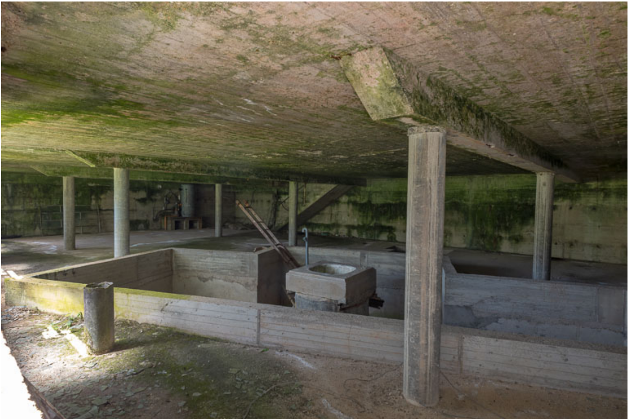
Aménagement du captage de la source, vue intérieure.
