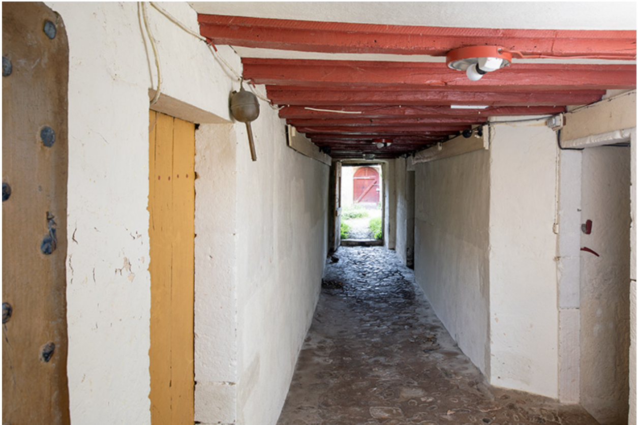
Couloir du rez-de-chaussée, vu depuis le jardin.
