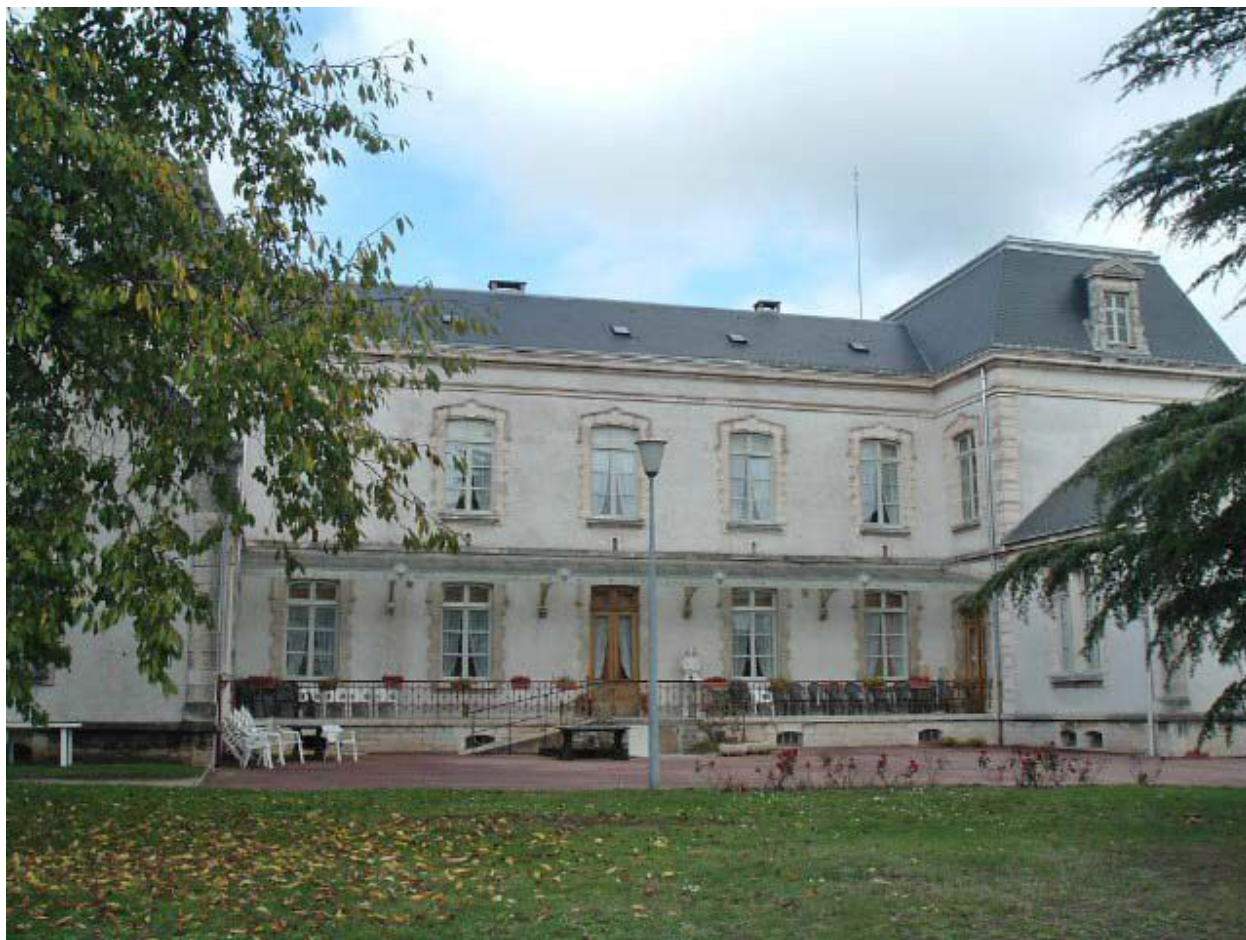
Vue générale de la façade antérieure.
