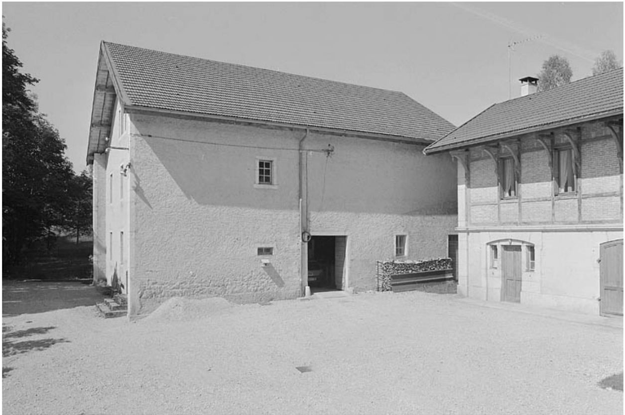
Face droite de la ferme et façade antérieure de la remise à automobile.
