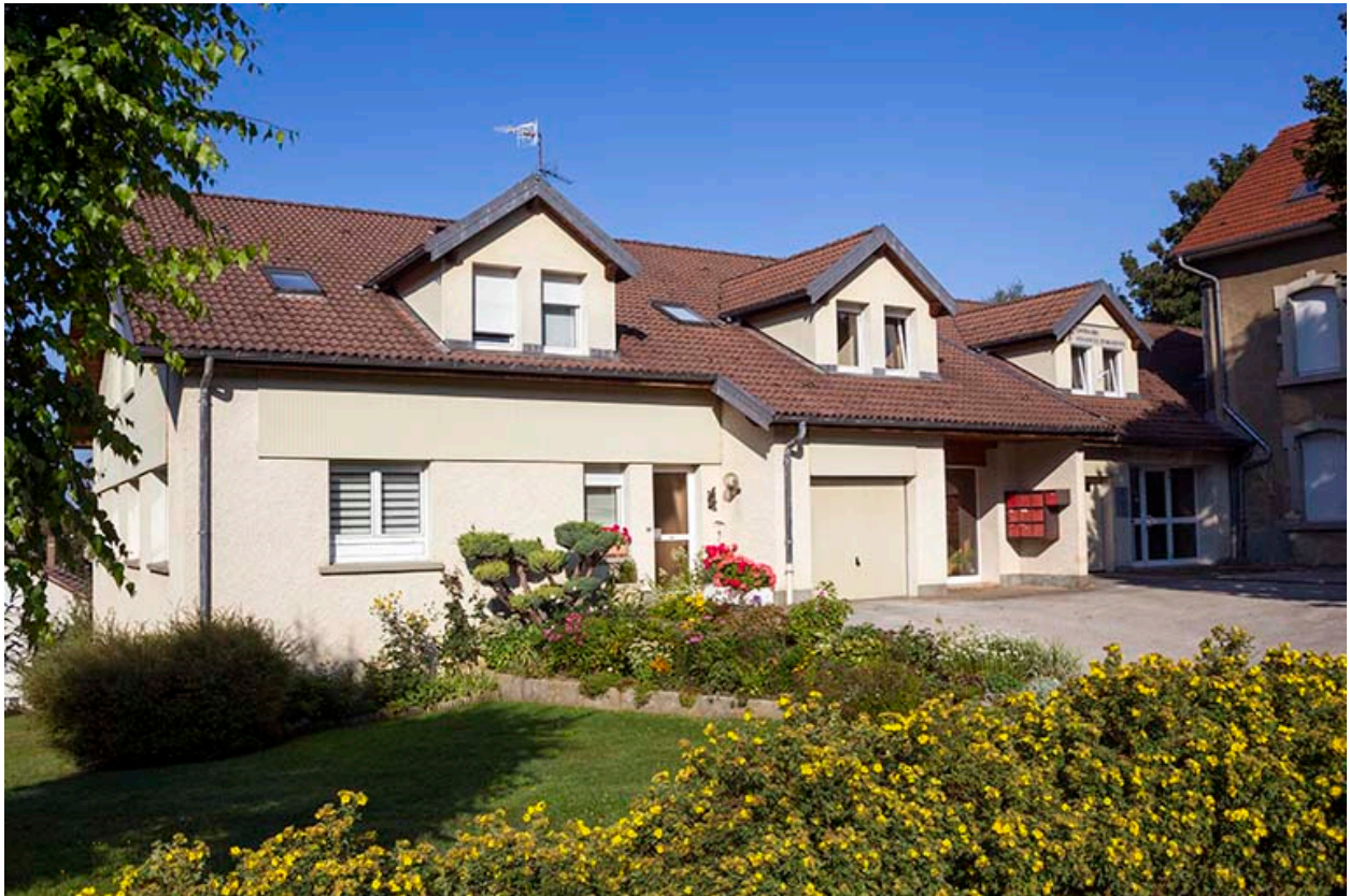
Ateliers de fabrication (immeuble à gauche et perception à droite) : façade antérieure.
