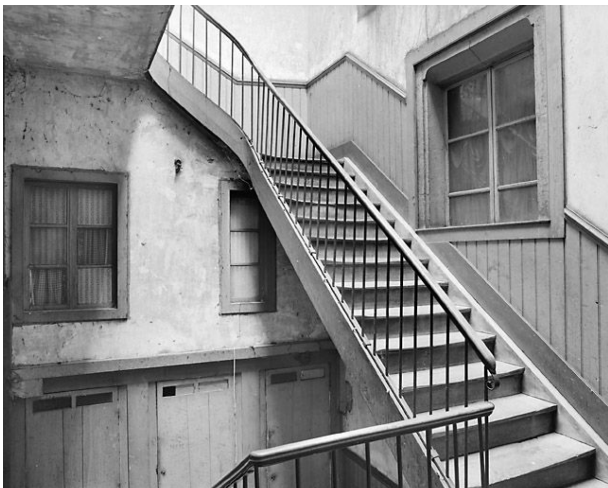
Escalier depuis le palier du premier étage.
