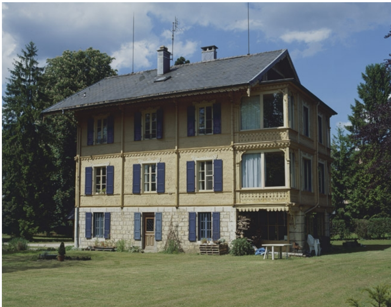
Chalet. Façade sud.
