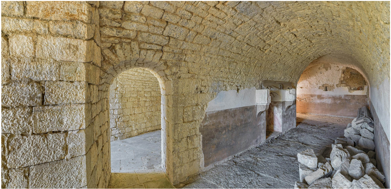
Salle casematée de l'étage avec cheminée.
