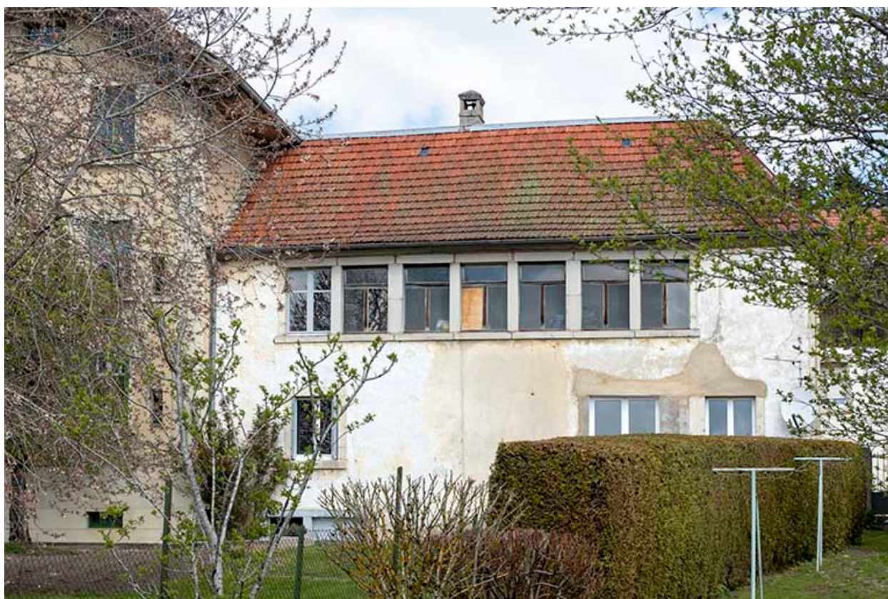
Façade postérieure de l'atelier.
