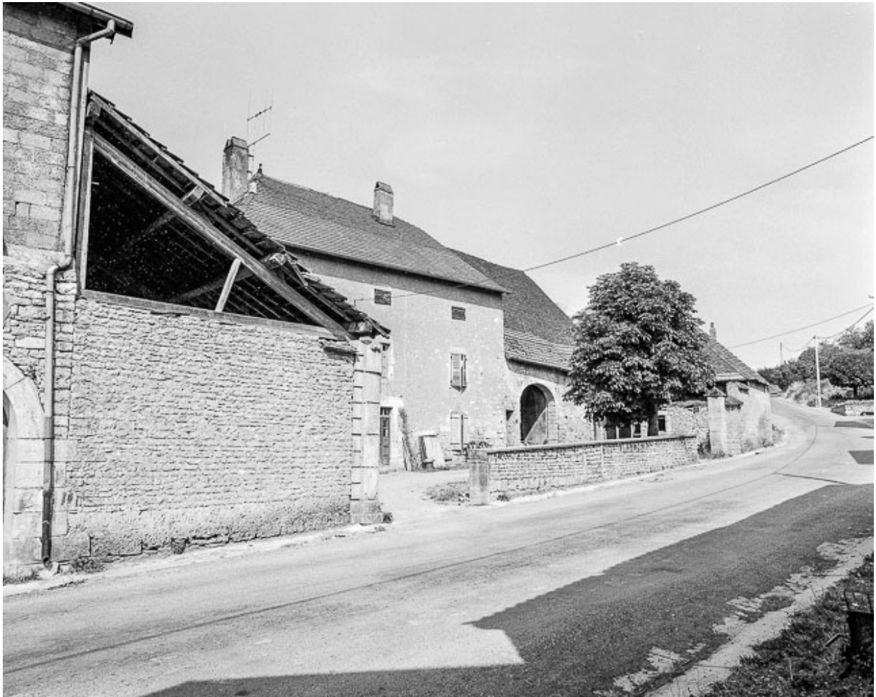
Ferme cadastrée 1973 AB 27 située rue d'Amont à Chenevrey : façade antérieure et cour.
