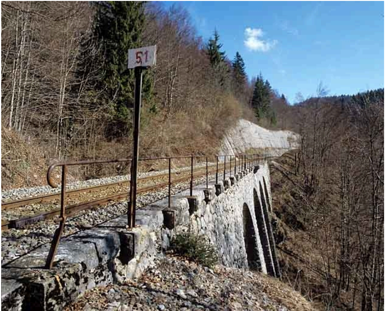
Vue d'ensemble en enfilade, depuis le sud-ouest.
