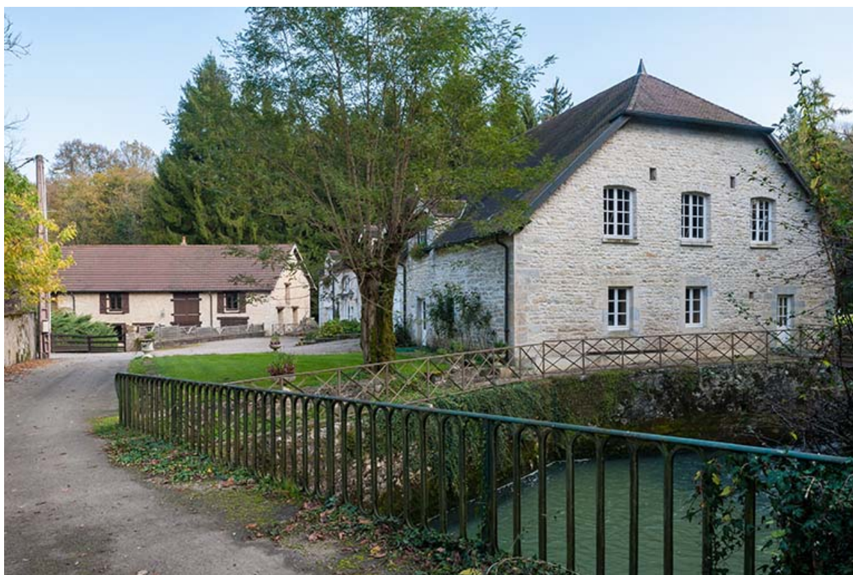
Vue d'ensemble depuis l'ouest.
