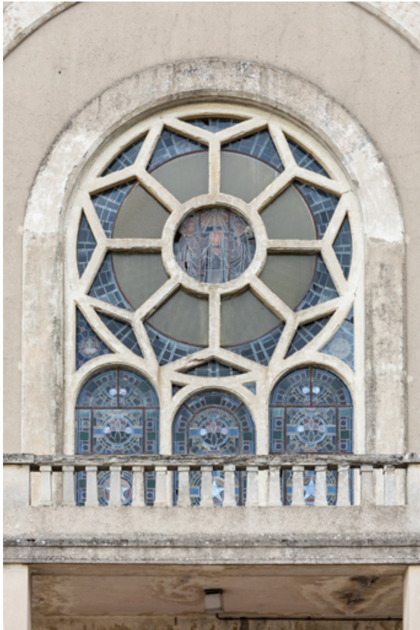
Verrière de la façade ouest. Vue extérieure.
