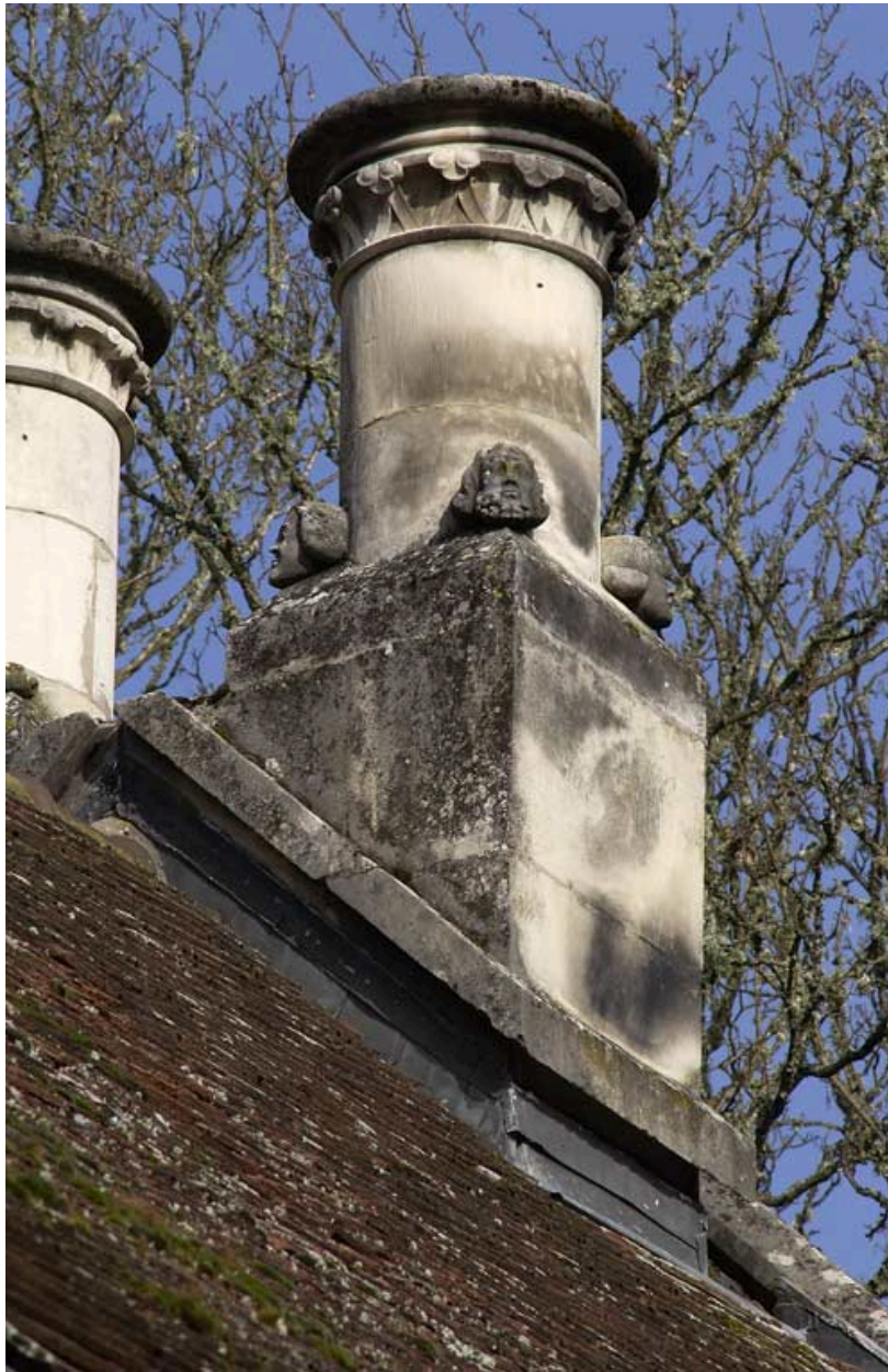
Bâtiment du réfectoire : souche de cheminée néo-gothique.
