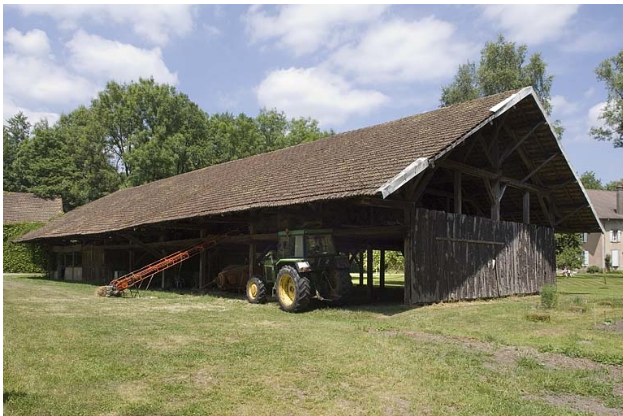
Entrepôt industriel vu depuis le sud.
