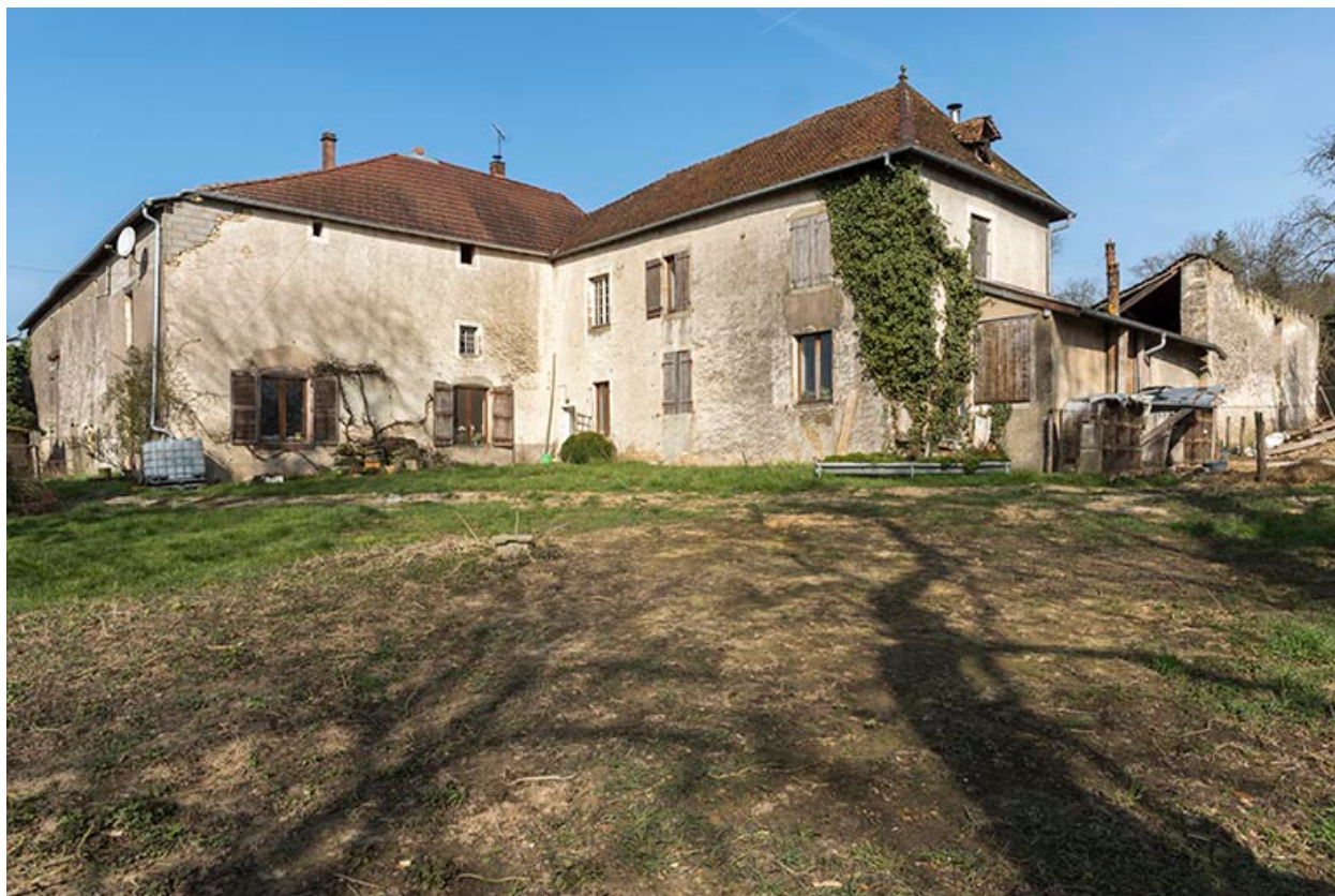
Vue générale, façade postérieure.
