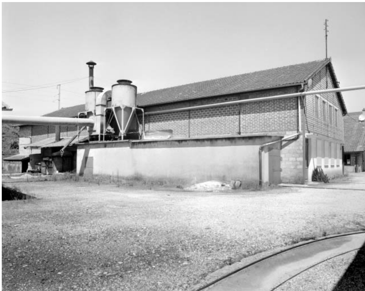
Atelier de fabrication, atelier de conditionnement, bureau.
