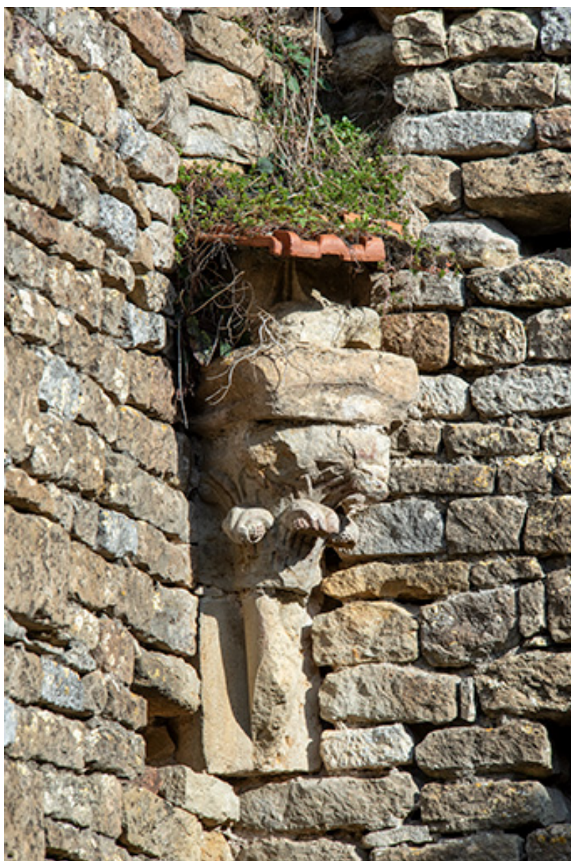
La chapelle nord attenante au chevet : détail du chapiteau dans l'angle nord-est.
