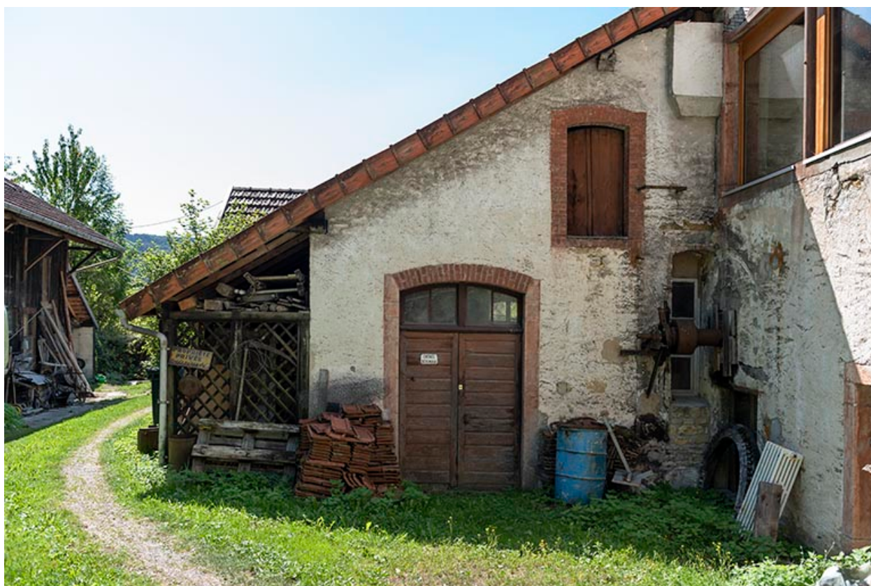
Bâtiment d'eau : façade antérieure.
