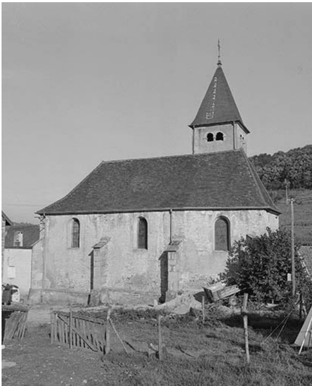
Extérieur : face latérale droite.
