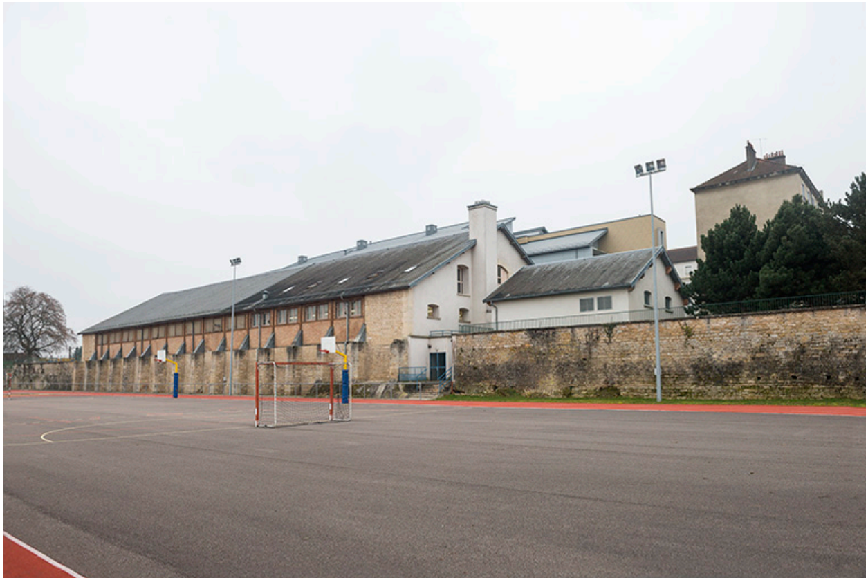
Terrain de sport, façade nord-est et pignon nord-ouest de l'ancien manège-atelier, vus du nord.
