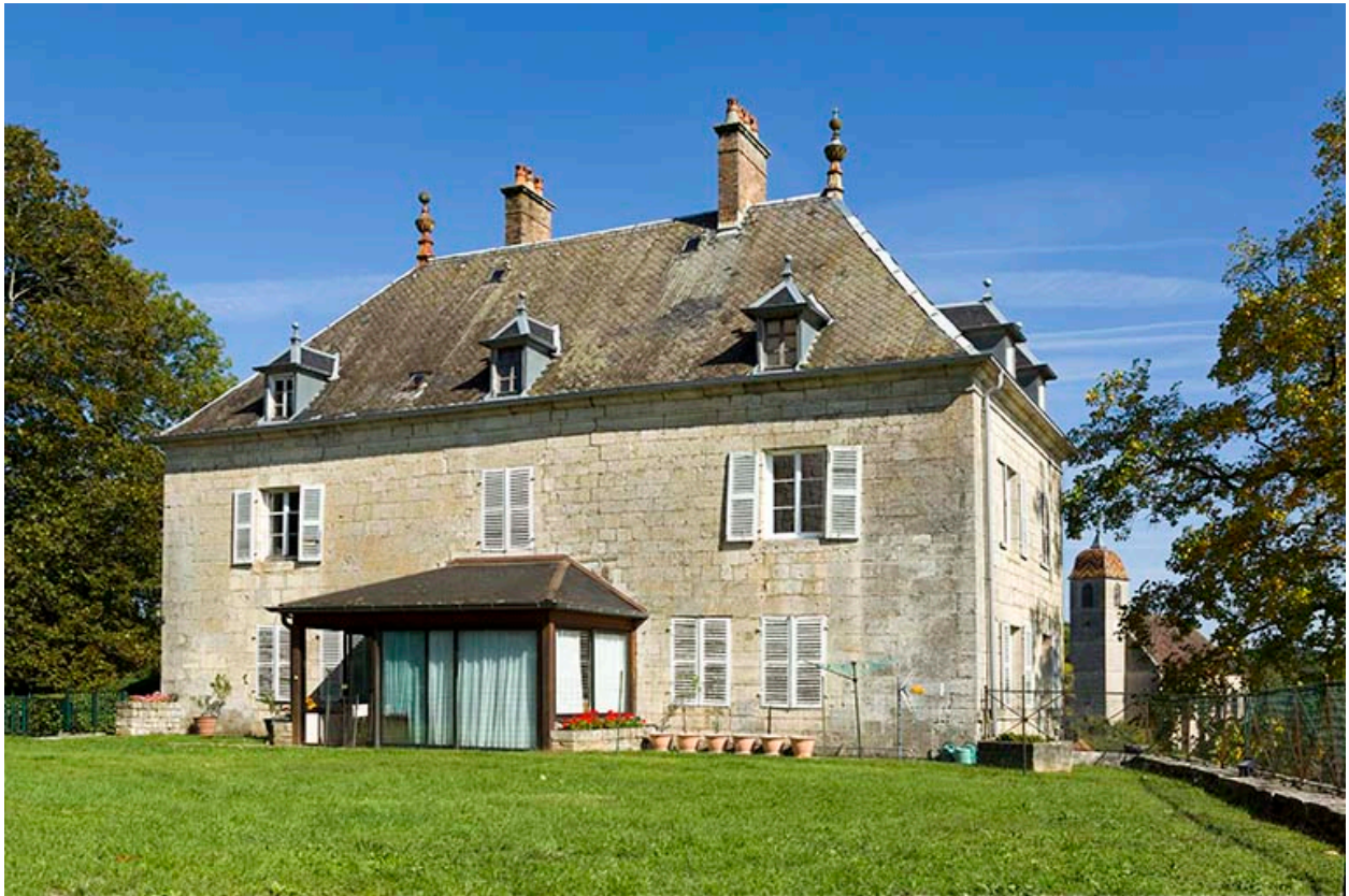
Façade antérieure et façade latérale droite.
