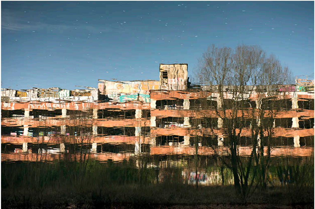
Etat en 2016. Usine A : reflet sur le Doubs de la façade sud des ateliers d'étirage et filature tergal et nylon.
