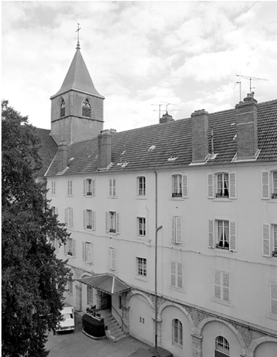
Bâtiments conventuels, cour intérieure, façade est.
