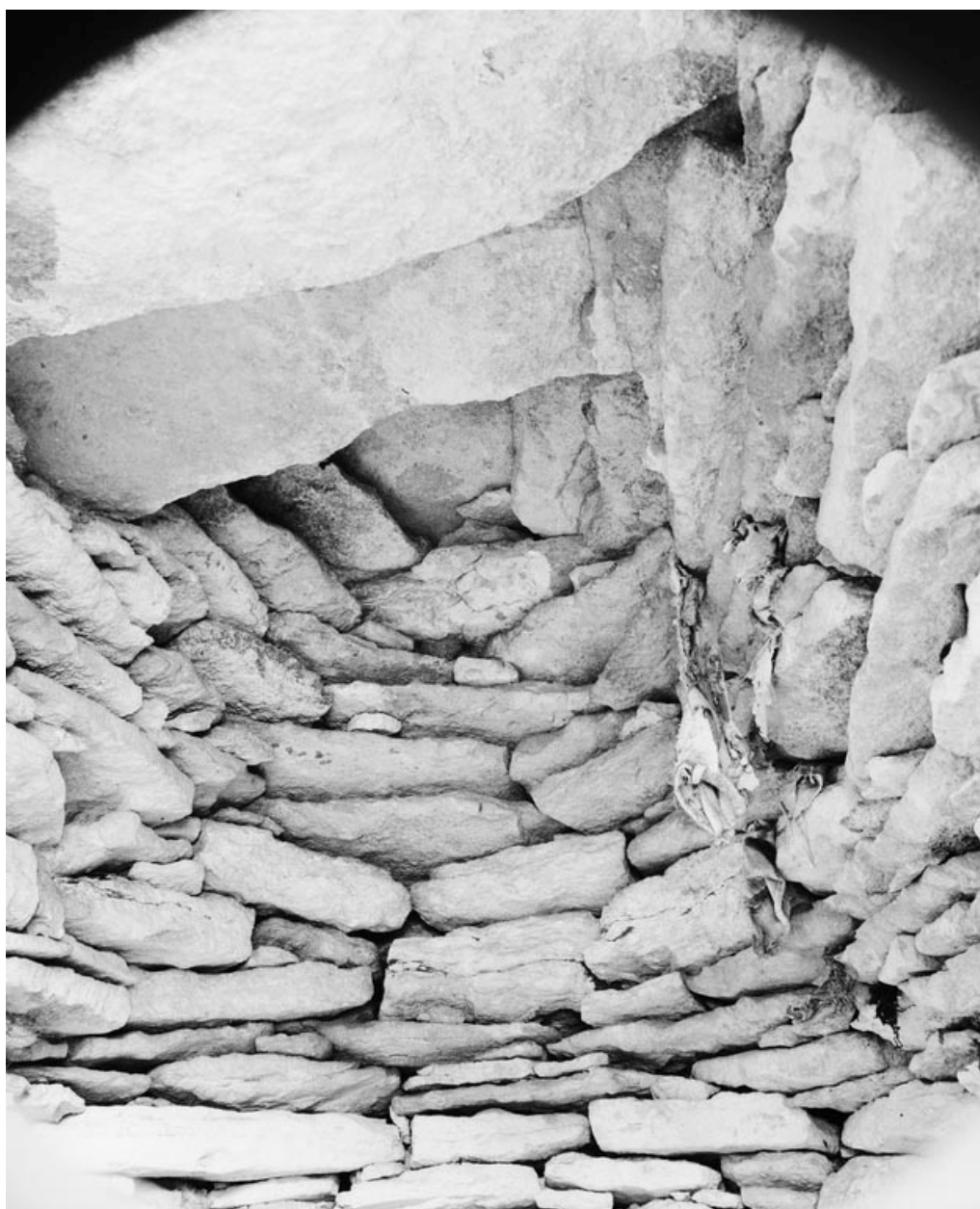
Détail de la voûte.
