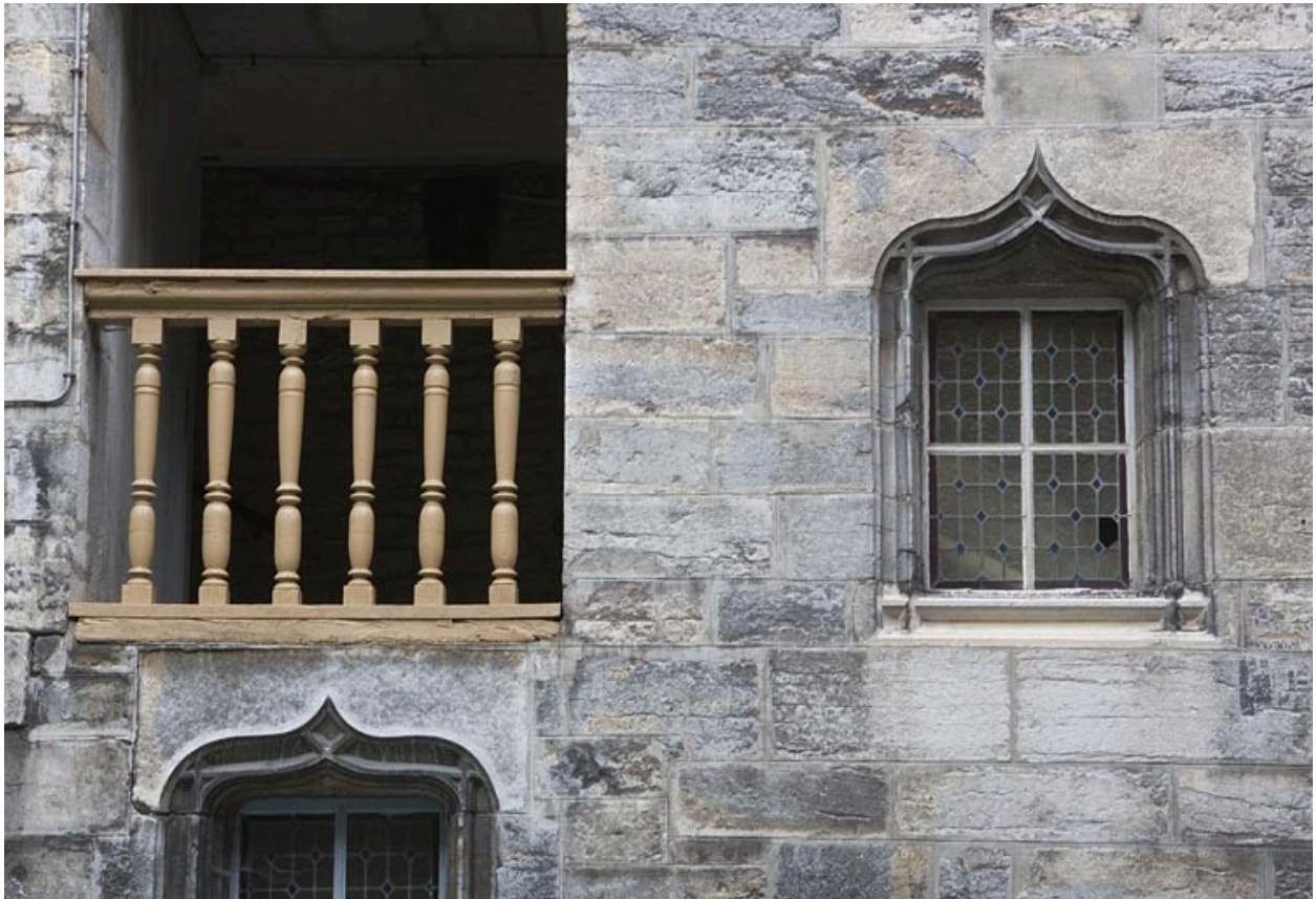
Détail d'une partie du soubassement de l'escalier à cage ouverte.
