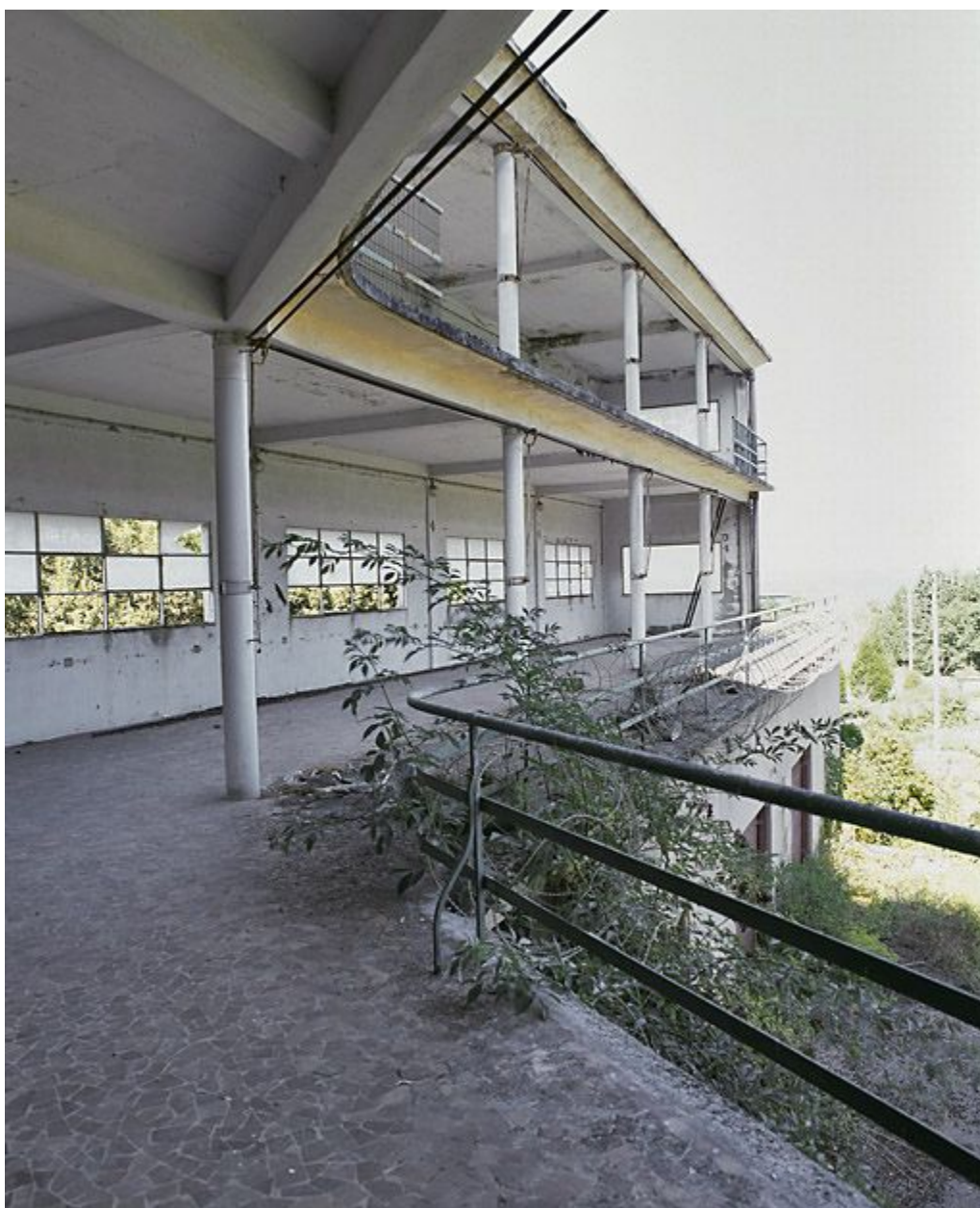
Galerie de cure est, façade sud-est.
