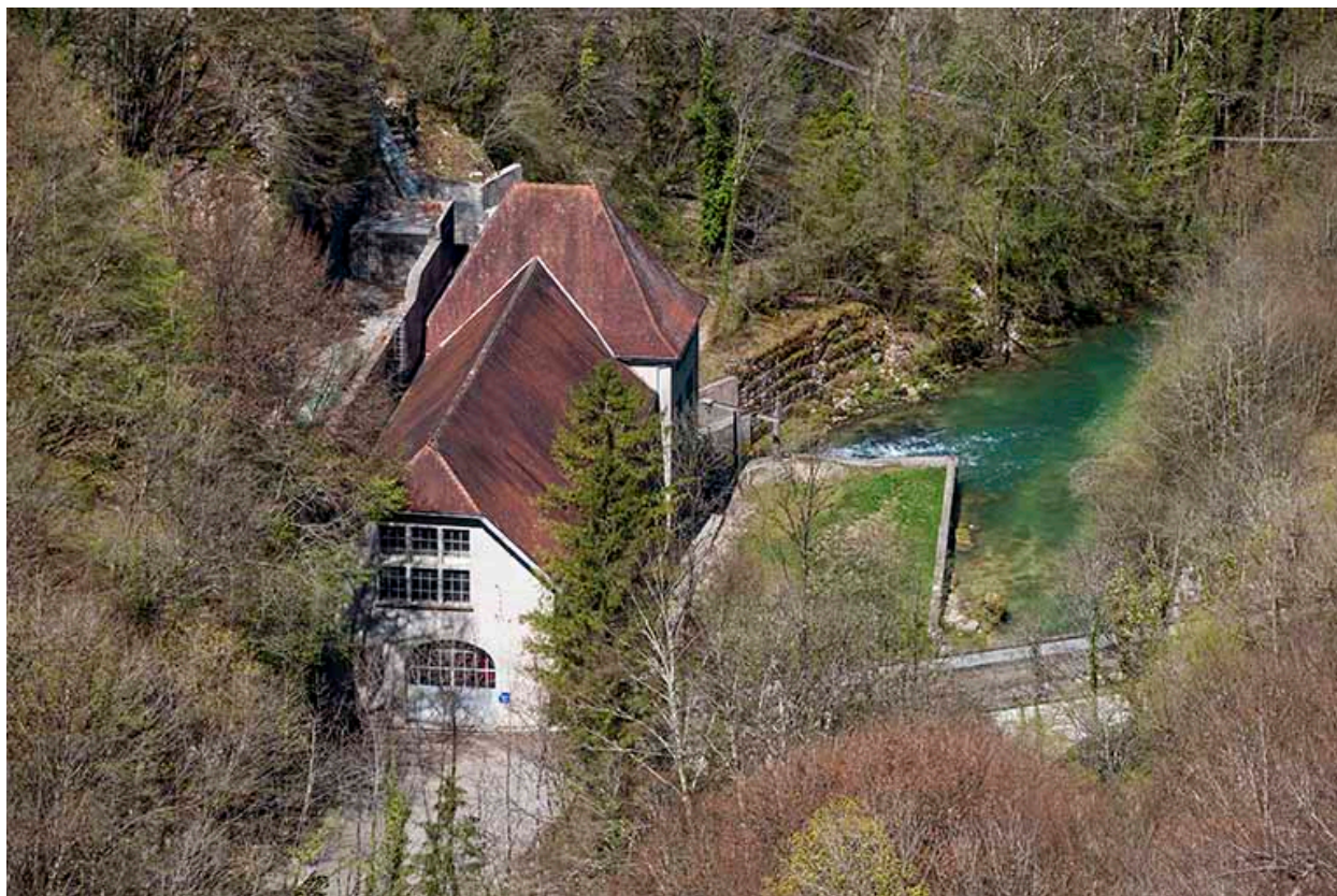
Centrale hydroélectrique de Mouthier, Mouthier-Haute-Pierre.
