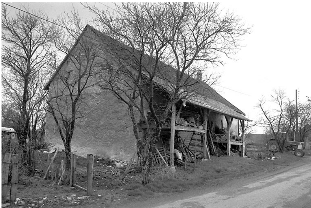
Vue d'ensemble de la façade antérieure.
