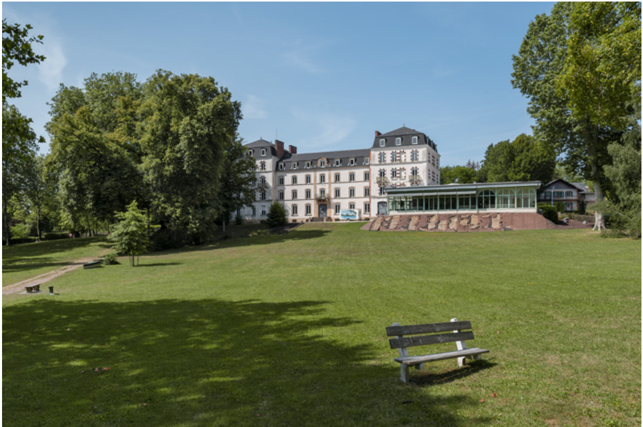
Vue d'ensemble depuis le parc thermal.
