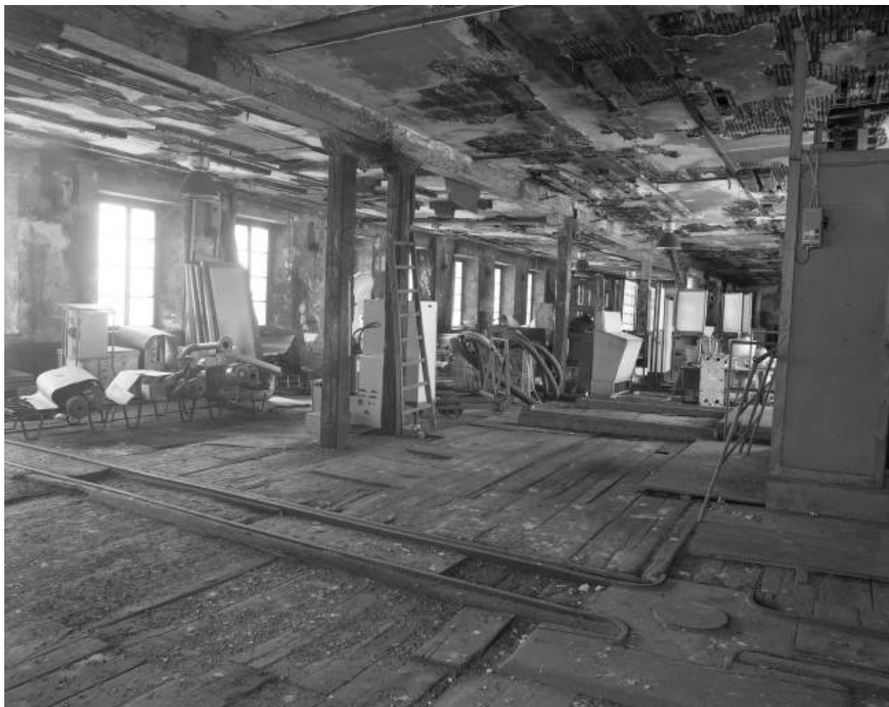
Atelier outillage-entretien mécanique. Premier étage.
