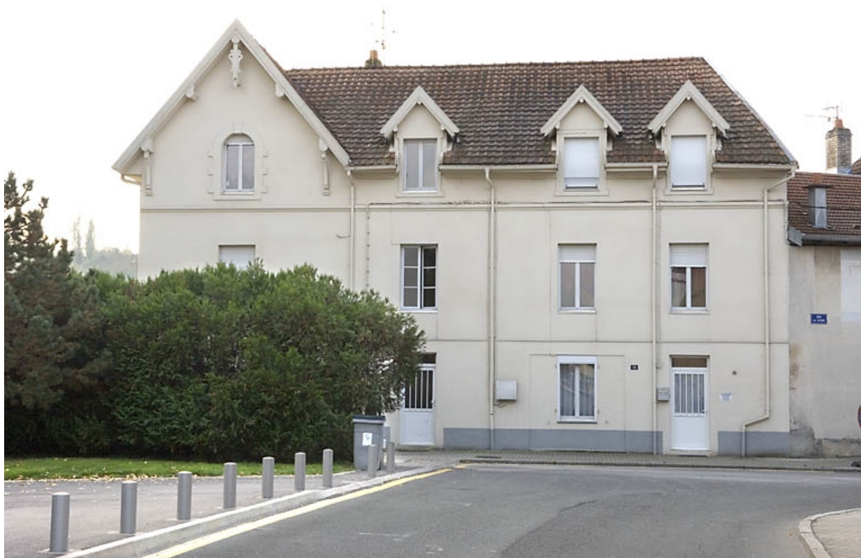
Logement ouvrier (?). Vue de face.
