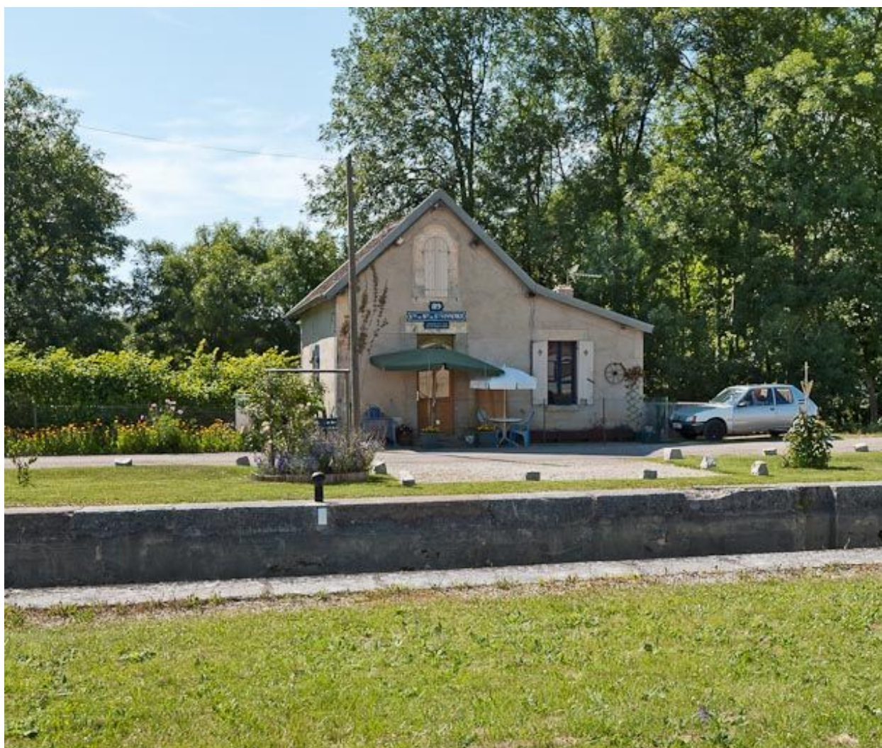
Vue de face de la maison éclusière.
