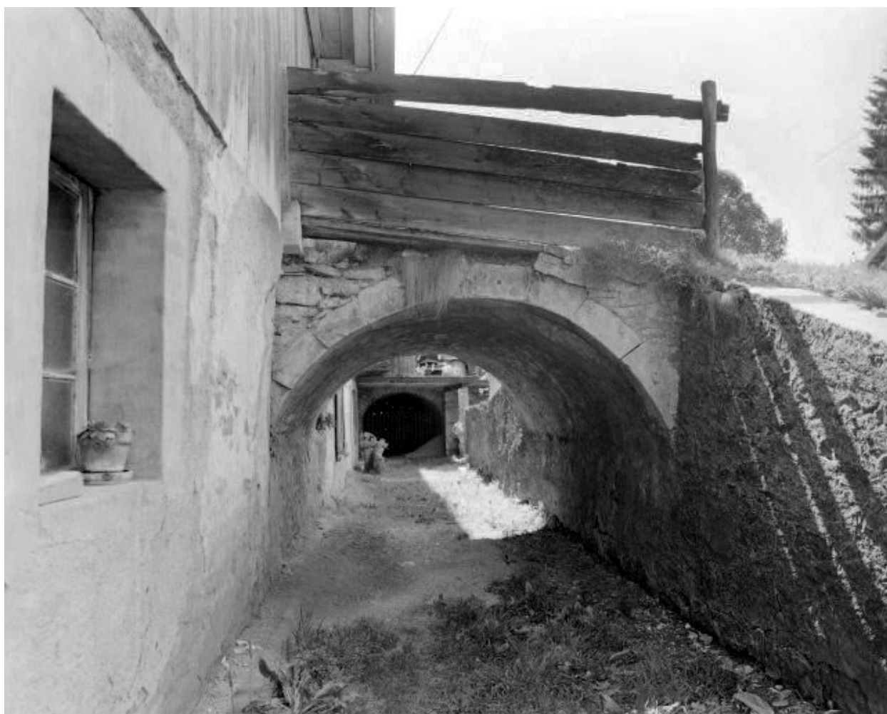
Façade antérieure : ponts de granges.
