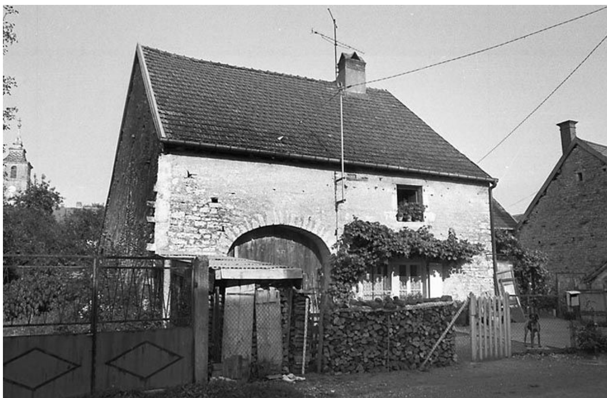
Ferme située 3 rue du Pont.
