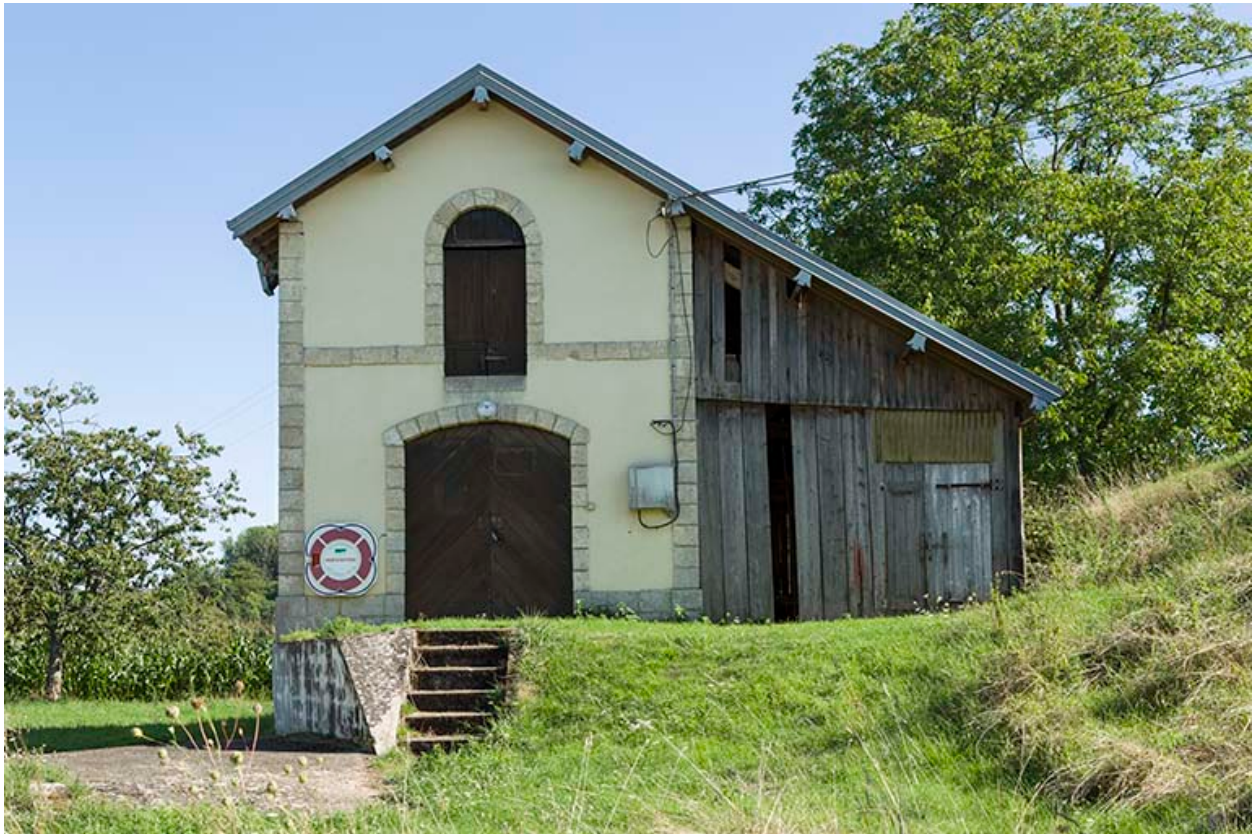
Vue du pignon nord du magasin avec date portée sur l'arc de la baie de l'étage.
