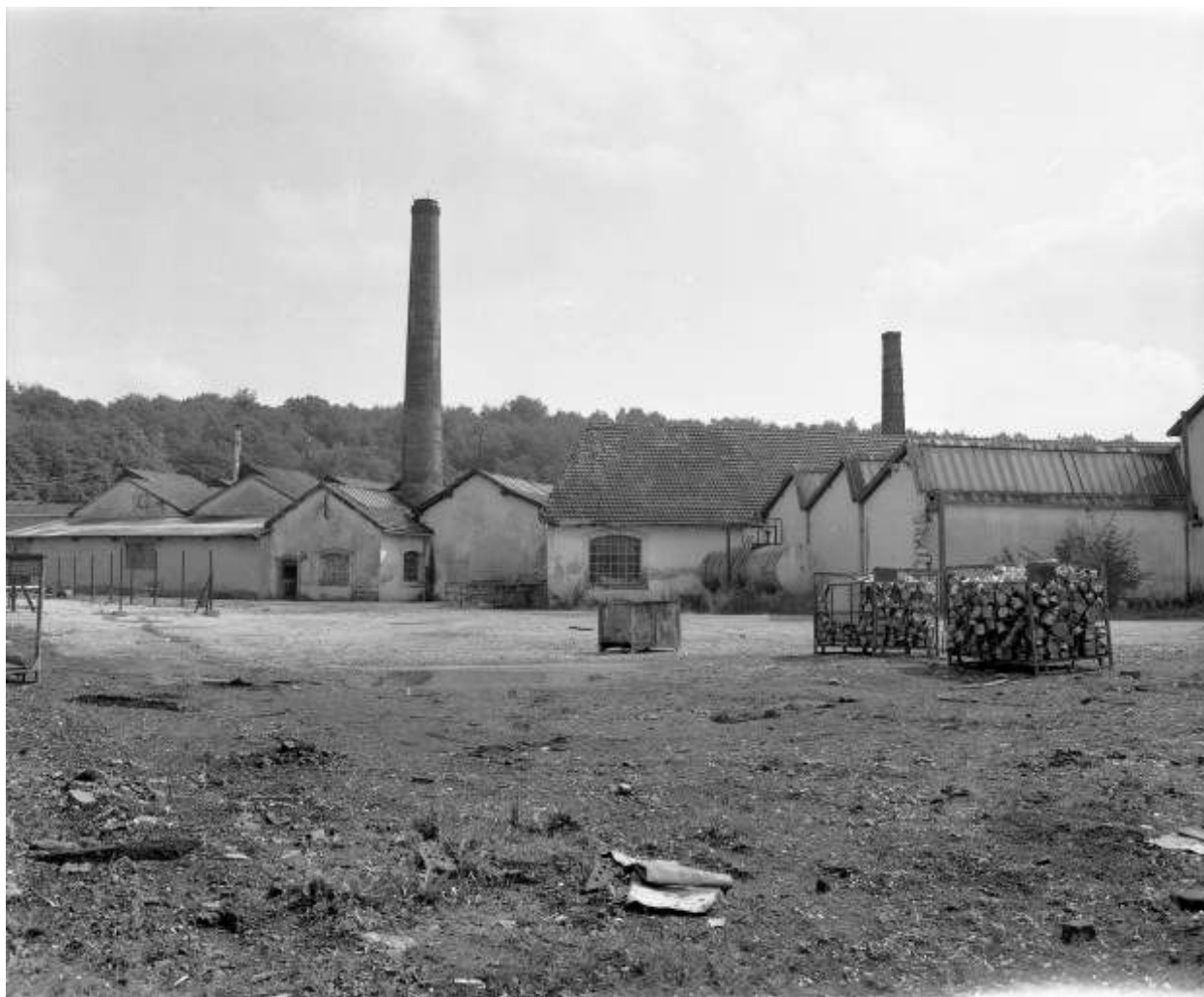
Ateliers de fabrication depuis l'ouest en 1981.
