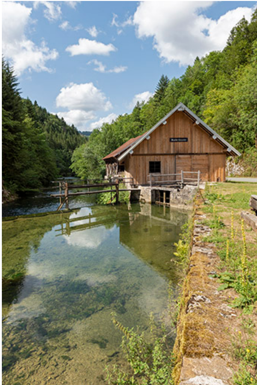
Scierie, depuis l'amont (sud).
