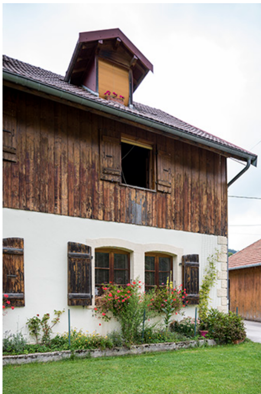
Façade antérieure : fenêtres horlogères.
