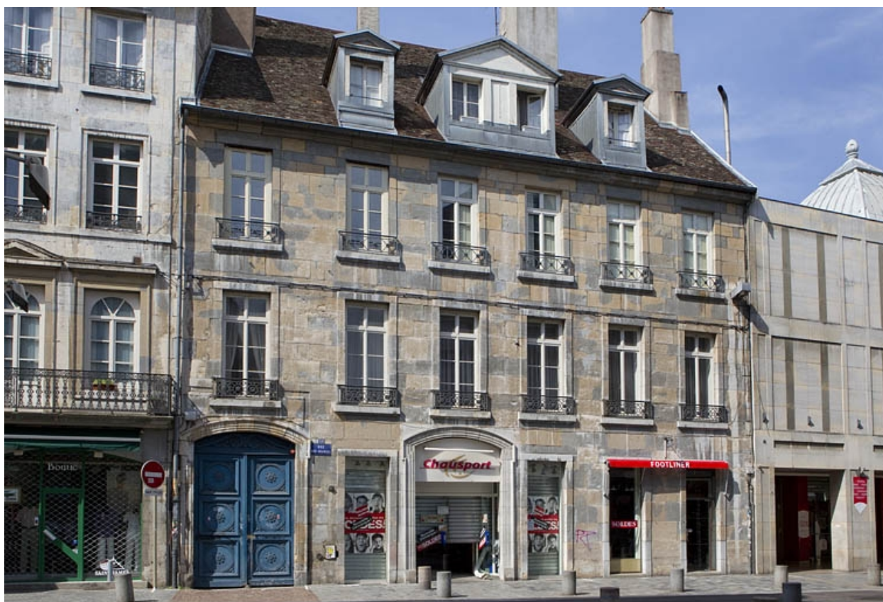
Vue d'ensemble de face depuis la rue.
