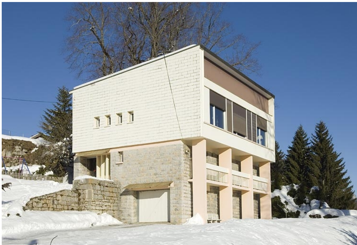
Vue de trois quarts depuis la cour.
